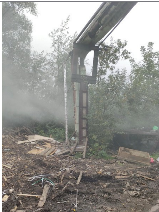
Рисунок 1.4 – Вертикальный компенсатор на тепловой сети 5ТК-12
