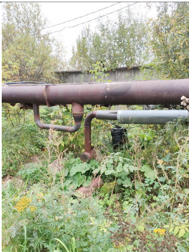
Рисунок 1.3 - Переход Ø 159 /Ø89 на тепловой сети 5ТК-12
